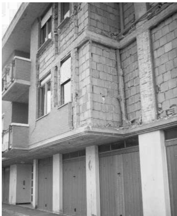
Figura 4.34 Ribaltamento totale di cortine in mattoncini non collegate alla struttura principale. Livello del danno per le tamponature: D4 (Fabriano, 1997)
