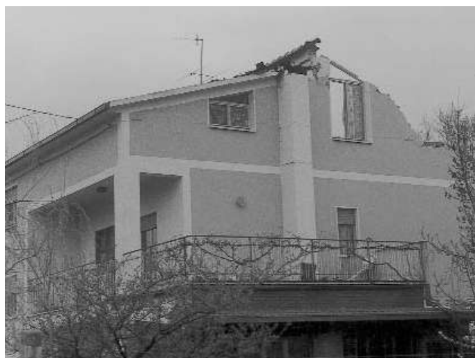
Figura 4.25 Crollo parziale di una copertura in travetti di cemento armato e tavelloni senza caldana. Livello del danno alla copertura: D4-D5
